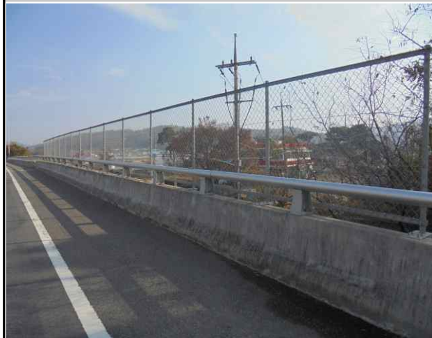
난간 및 연석 전경
